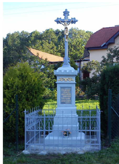
Litinový kříž po opravě.
