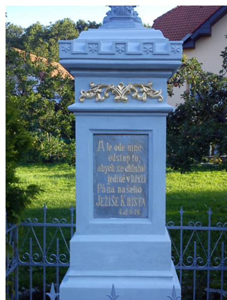
Kříž v České Rybné po opravě
