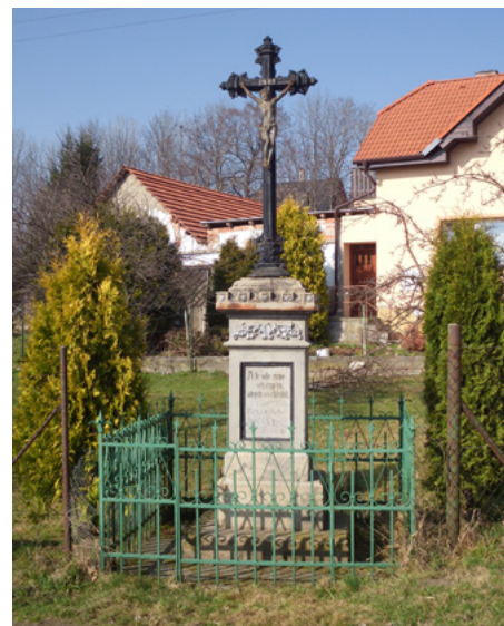
Litinový kříž před opravou.
