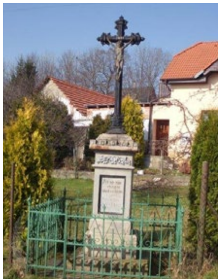
Kříž v České Rybné před opravou
