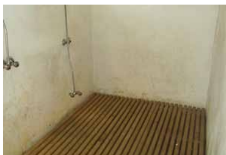
sprchy před rekonstrukcí
